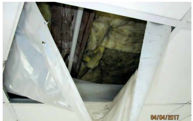
Bsp.: 8\_KMF-Matten hinter abgehängter Decke
